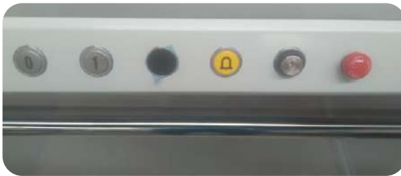
Imagen 4: Botonera estándar y luminoso de sobrecarga activado
